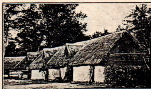
GALOPPATOIO DI BAUDENASCA - SCUDERIE (1900)
