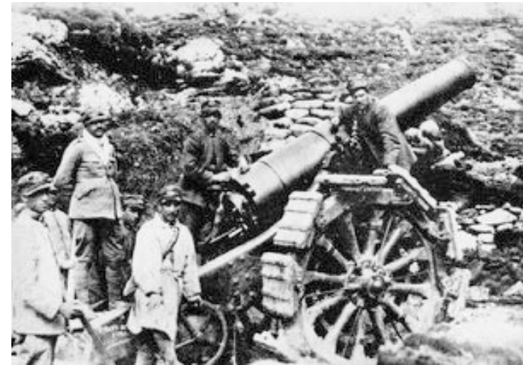
Figura 6 (a e b) - Due immagini che ben rappresentano l'applicazione del brevetto delle ruote a cingolo ideate da Bonagente
