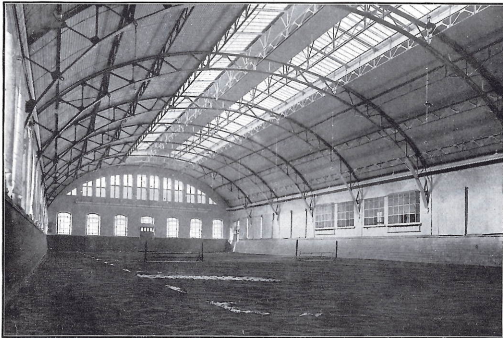
MANEGGIO CAPRILLI: INTERNO.
